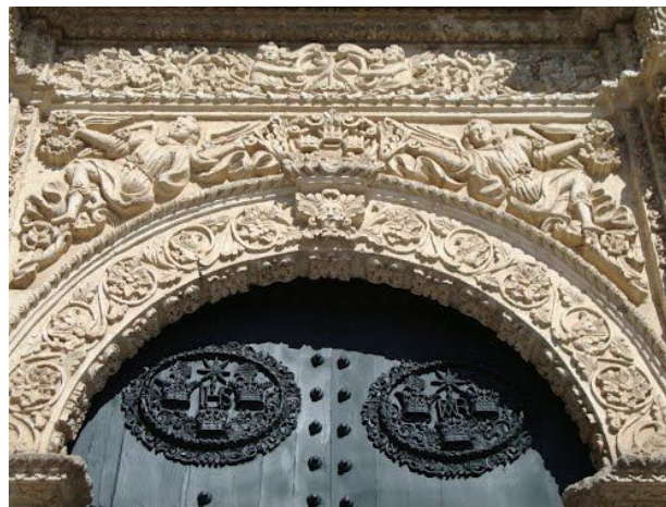
Fig. 21 y 22. Hospital Betlemita de Cajamarca
