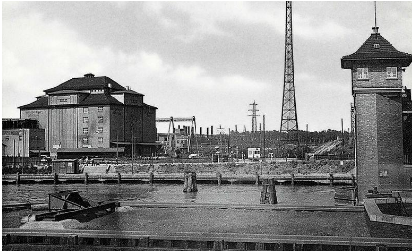
Imagen 2. Almacén frigorífico y puente ferroviario en Kosse, Königsberg (1928) 191
