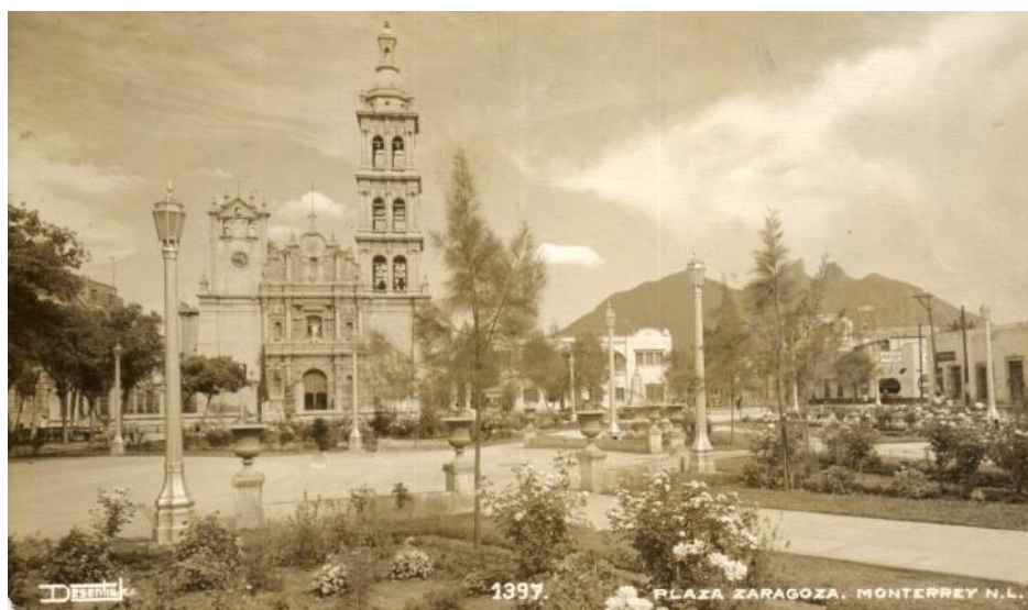
Imagen 1. Plaza Zaragoza, Monterrey 190
