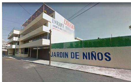
Colegio Enrique Rébsamen: ampliación ilegal en el edificio. Fuente: Google Earth.
