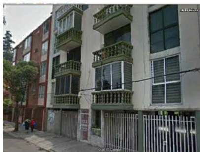
Evidencia de cimientos insuficientes para el tamaño de la construcción en vivienda, Colonia Portales Delegación Benito Juárez. Fuente: Google Earth.
