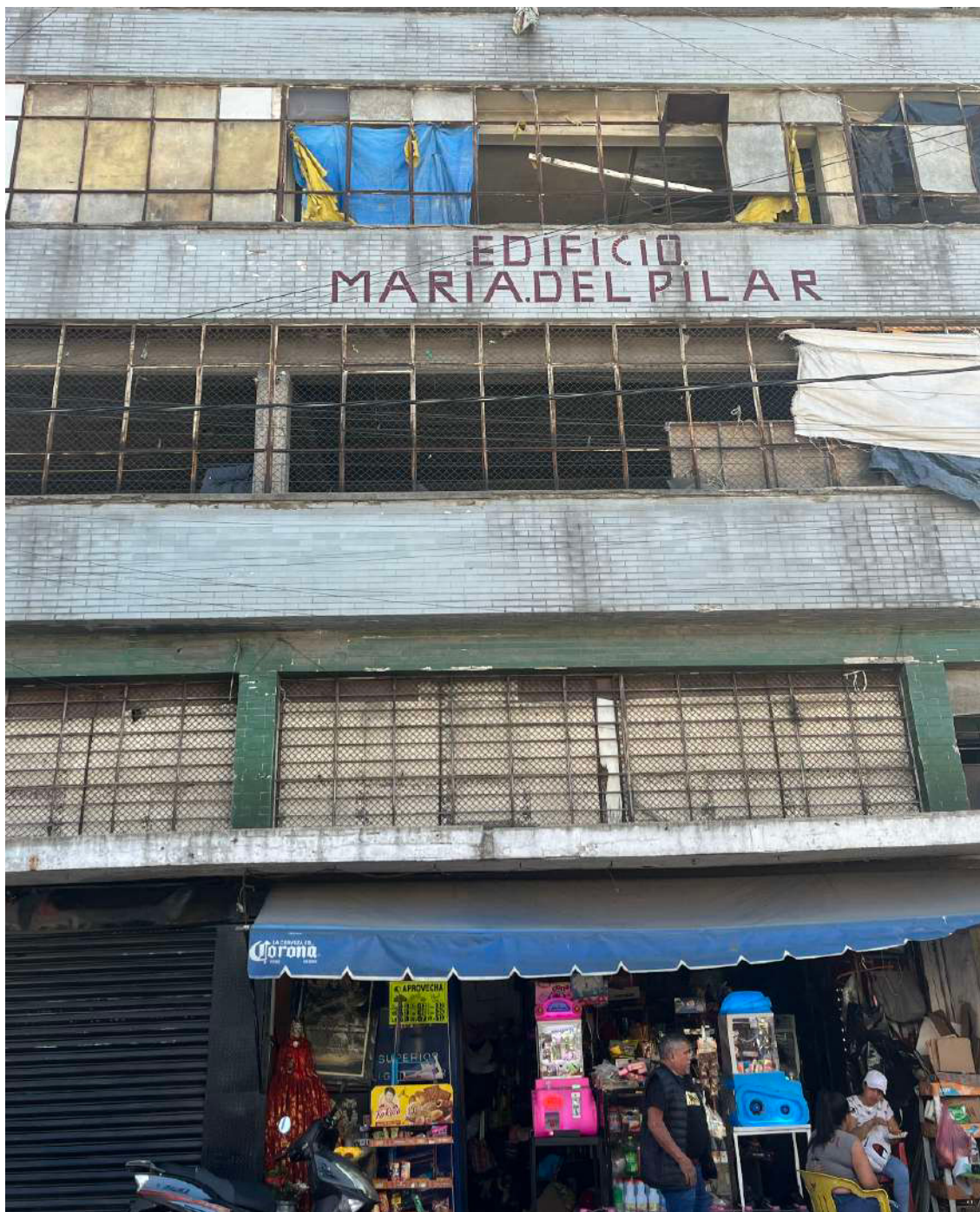
Edificio María del Pilar, en Matamoros y Tenochtitlan. En planta baja se aprecia un ejemplo del comercio fijo, aunque los 4 pisos superiores del edificio se encuentran abandonados.
