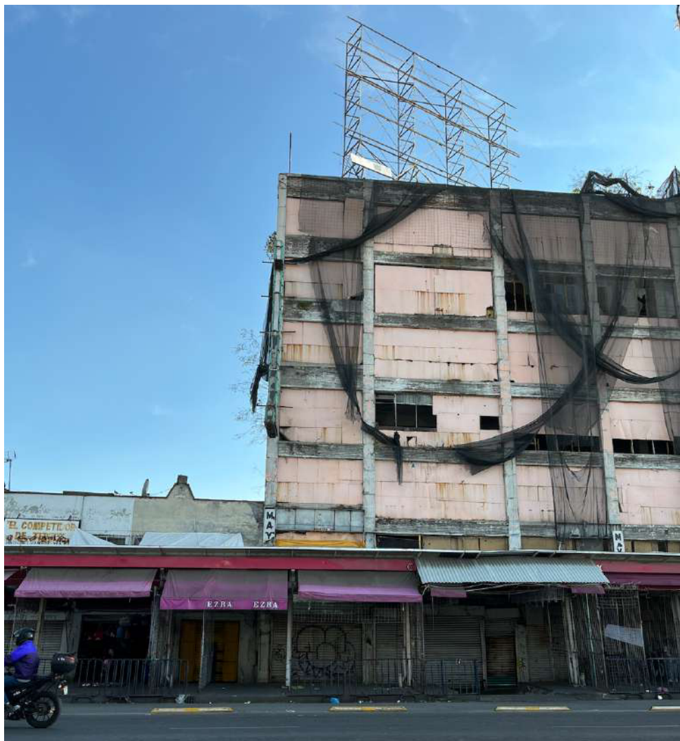
Edificio abandonado sobre el Eje 1 Norte. De acuerdo con El Urbanista, su estado actual se debe a que hay conflictos entre los distintos propietarios del inmueble.
