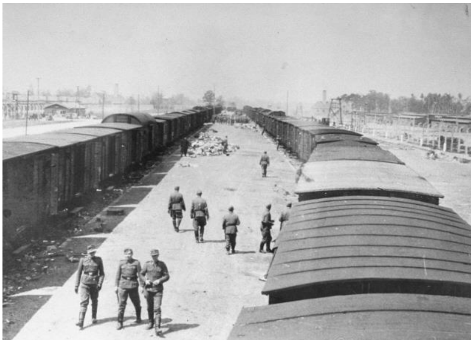
Figura 9. Dos trenes ocupan las vías del ramal ferroviario de Auschwitz II. El transporte de la izquierda ha sido vaciado. Las puertas de los vagones del otro tren están a punto de ser abiertas.
