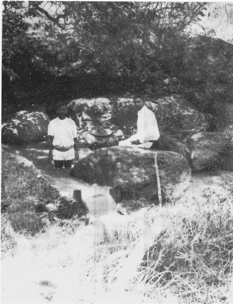
“Vertedor instalado en el río Ahuisculco antes de la toma comunal del canal de San Juan”, Ahuisculco, Jalisco (c. 1921-1922), AHA, Aprovechamientos Superficiales, caja 474, exp. 7901, f. 114, foto 1.
