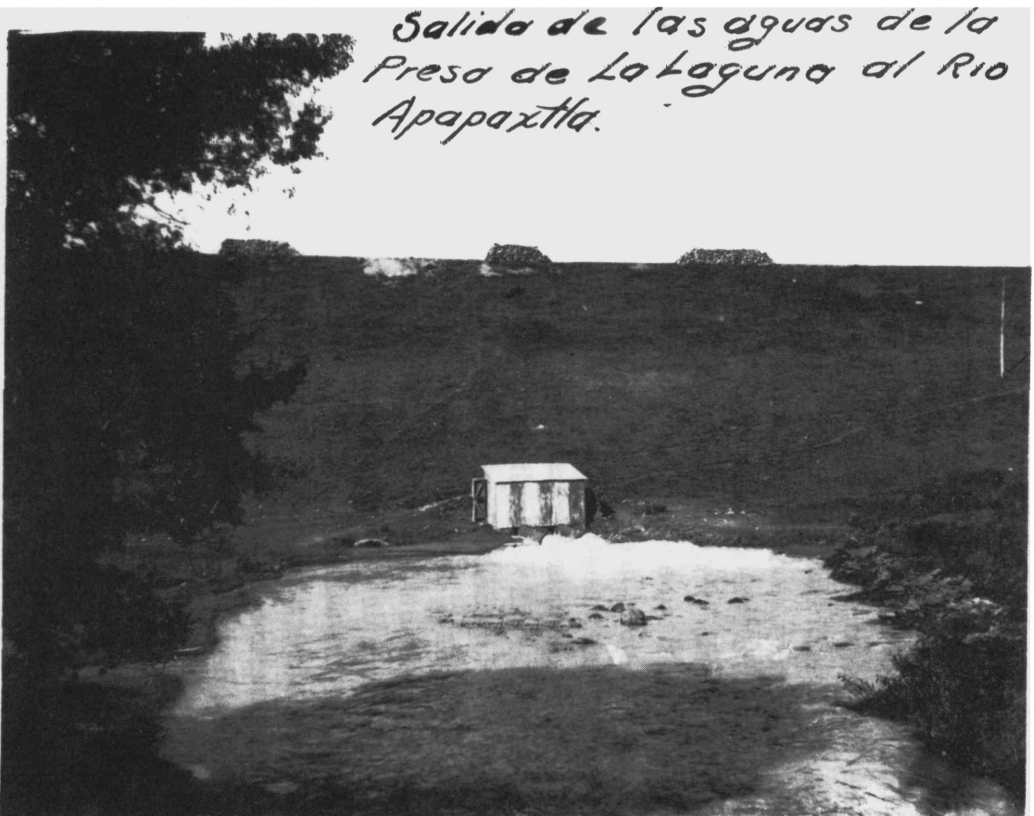
"Salida de las aguas de la Presa de la laguna al río Apapaxtla", Acaxochitlán, Hidalgo (1927), AHA, Aprovechamientos Superficiales, caja 258, exp. 6211, f. 34.
