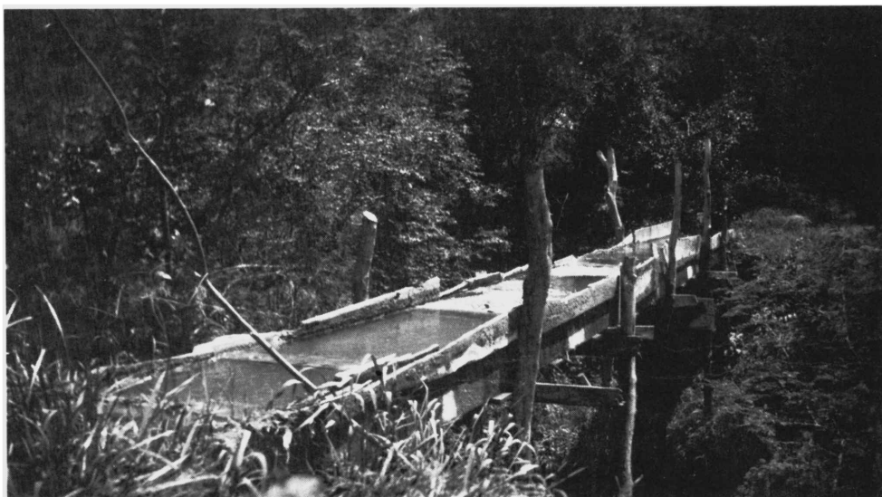
“Puente canal”, Linares, Nuevo León (1928), AHA, Aprovechamientos Superficiales, caja 1050, exp. 14798, f. 360, foto 2.
