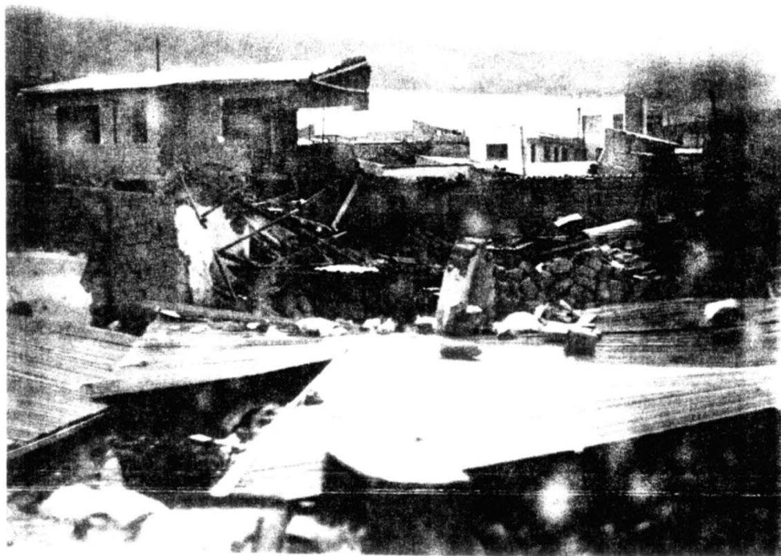
Arriba, coliseo de Viacha: "palacio del deporte", recién techado, 2001. Abajo, casas derrumbadas por las riadas (Viacha) enero del 2001.
