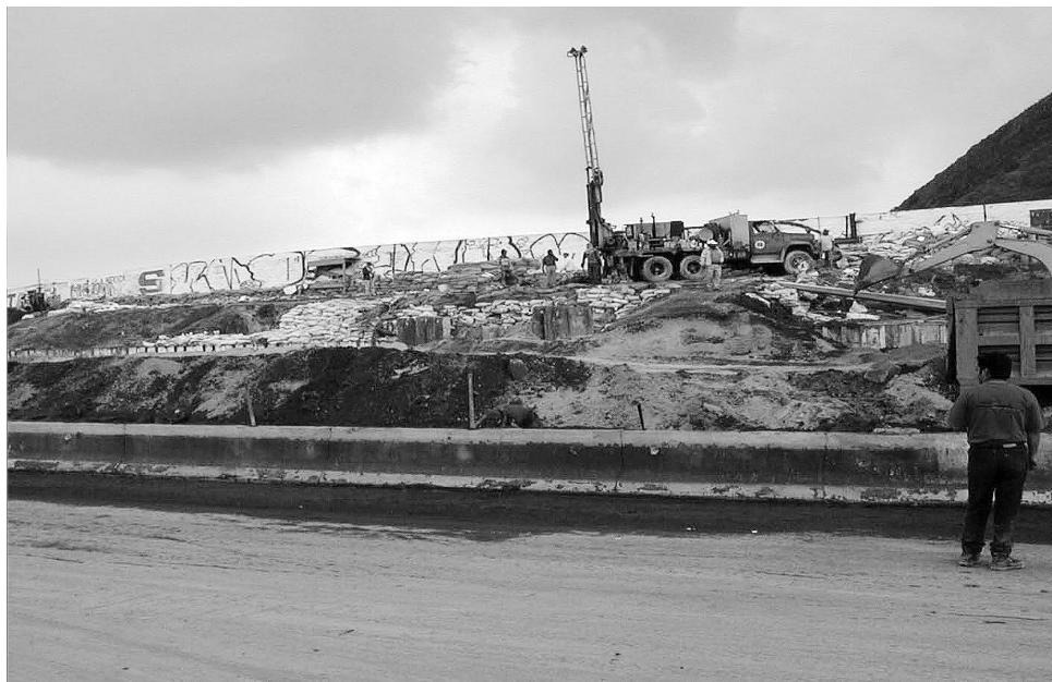
FIGURA 1 Obras de mantenimiento en el canal de La Compañía
