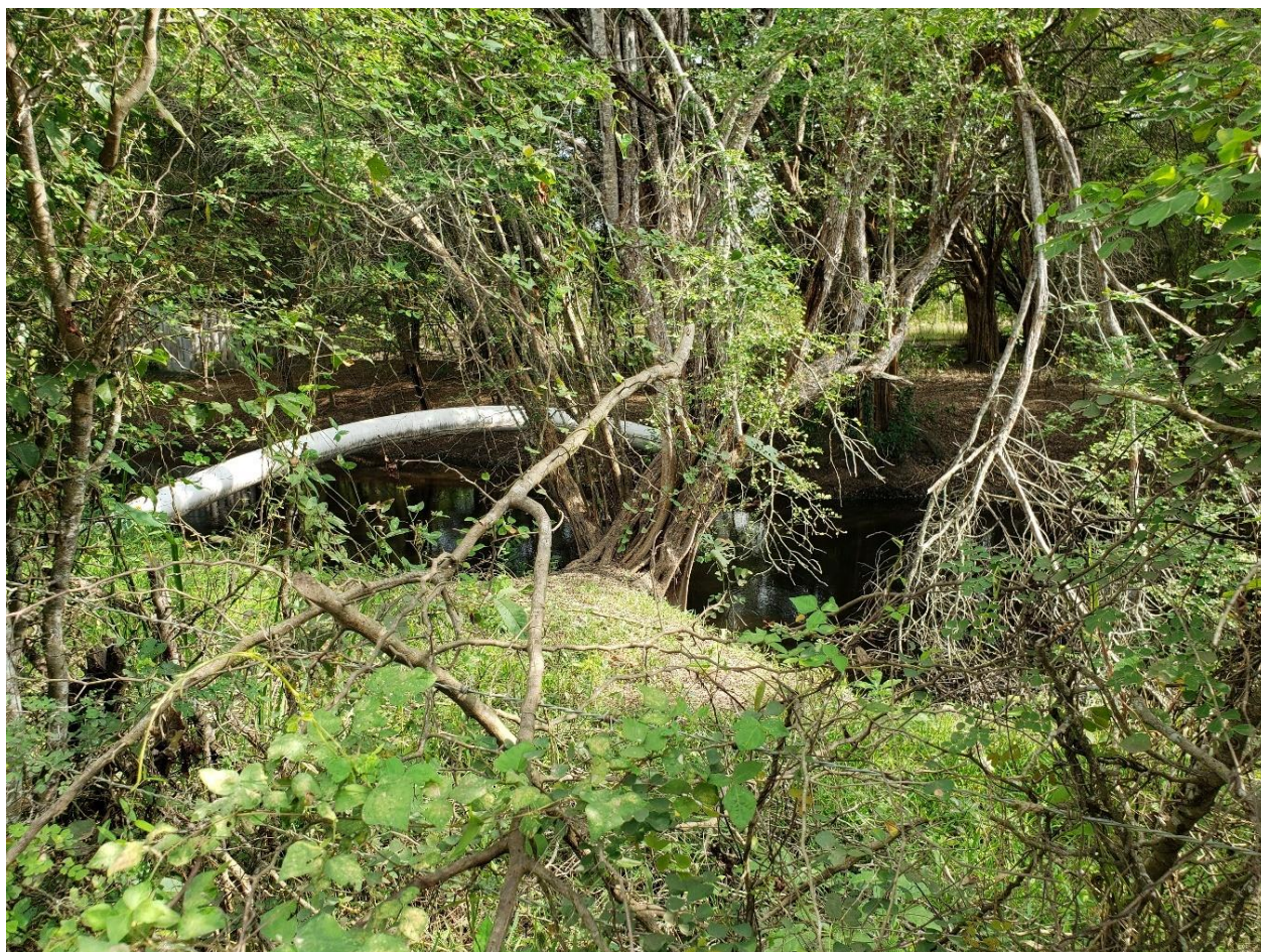
Ilustración V.2. Cruce de oleoducto sobre dren paralelo a camino rural, rumbo a batería Oxiacaque. Fuente: fotografía propia.
