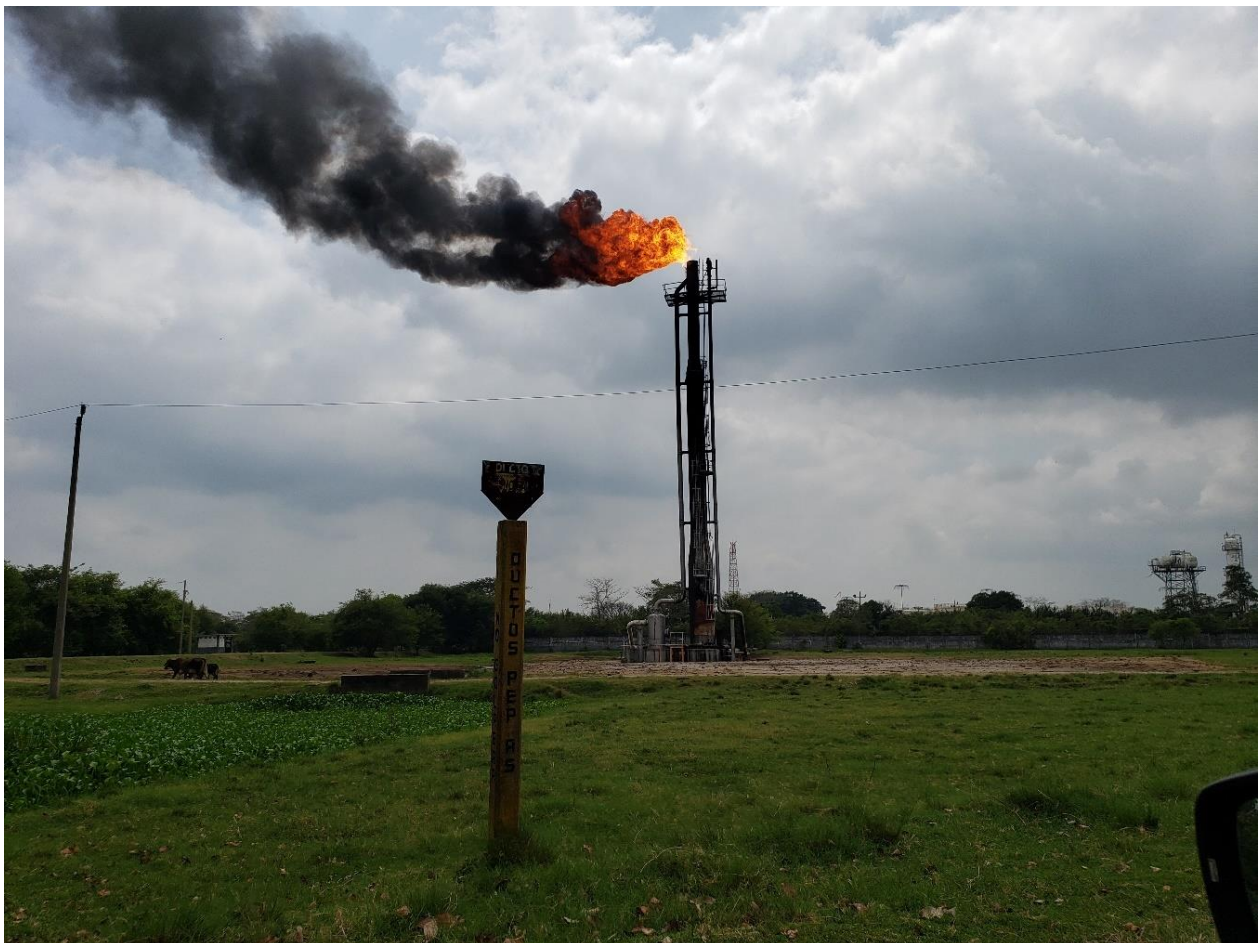
Ilustración VI.2. Quemador cerca de la ranchería Gregorio Méndez, Cunduacán. Fuente: fotografía propia.
