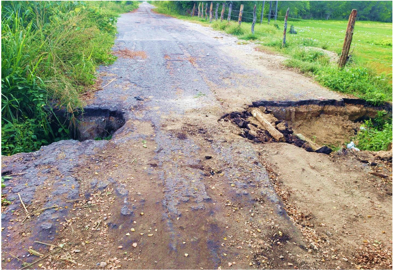
Ilustración V.3. Camino rural Cunduacán – Bordo izquierdo, que corre paralelo al dren. Fuente: fotografía propia.
