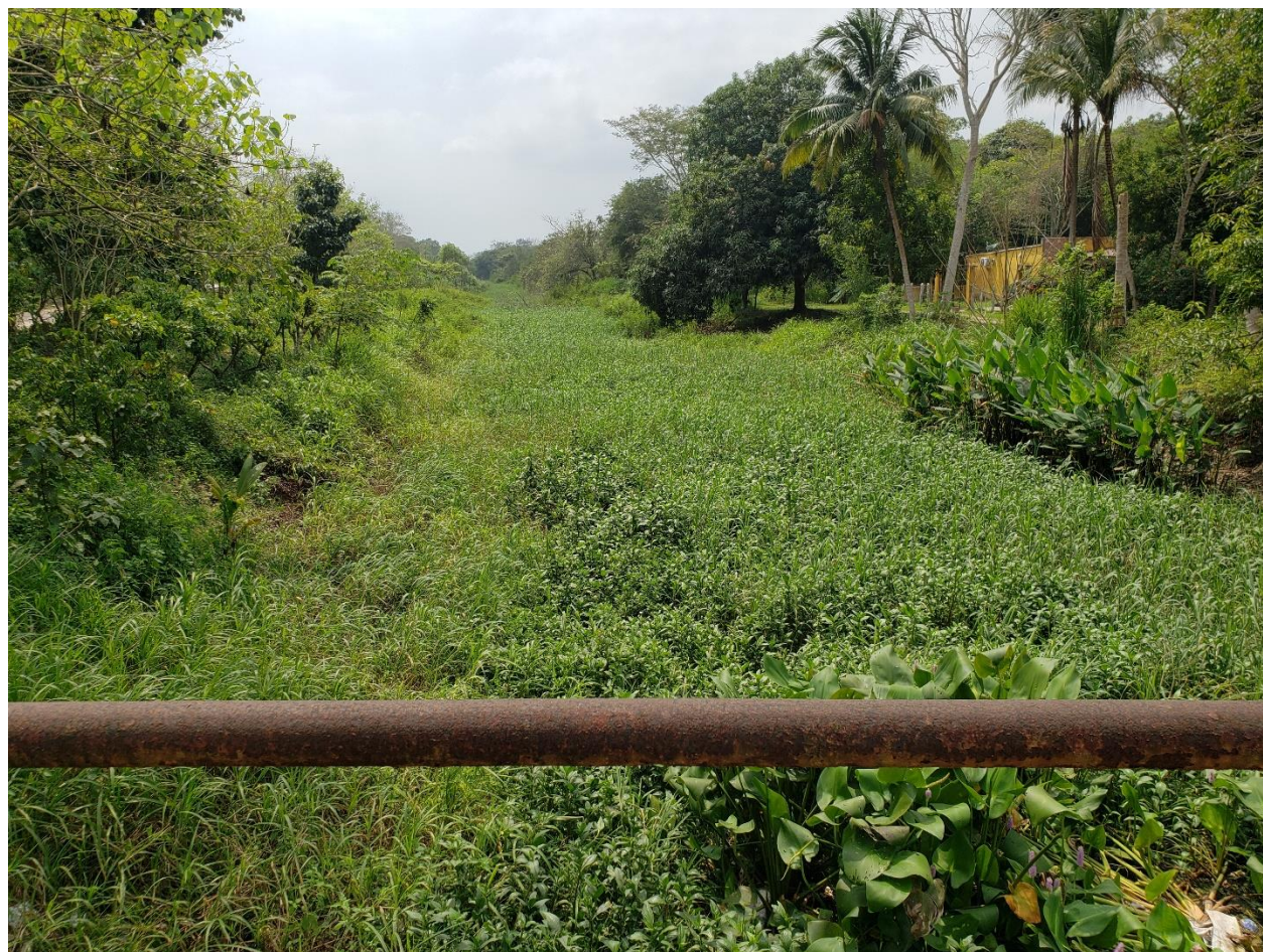
Ilustración VI.1. Dren junto a la ranchería de Santa Lucía, Jalpa de Méndez. Fuente: fotografía propia.
