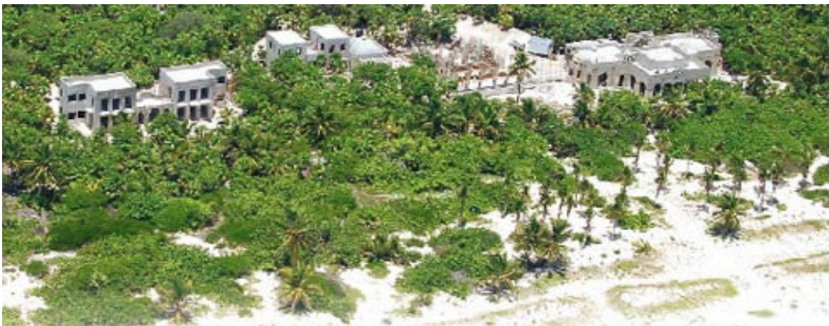
Vista aérea de la Casa Palancar, una de las "casas habitación" que actualmente se están construyendo en la reserva de la biosfera de Sian Ka'an- (Crédito: diario Quequi).
