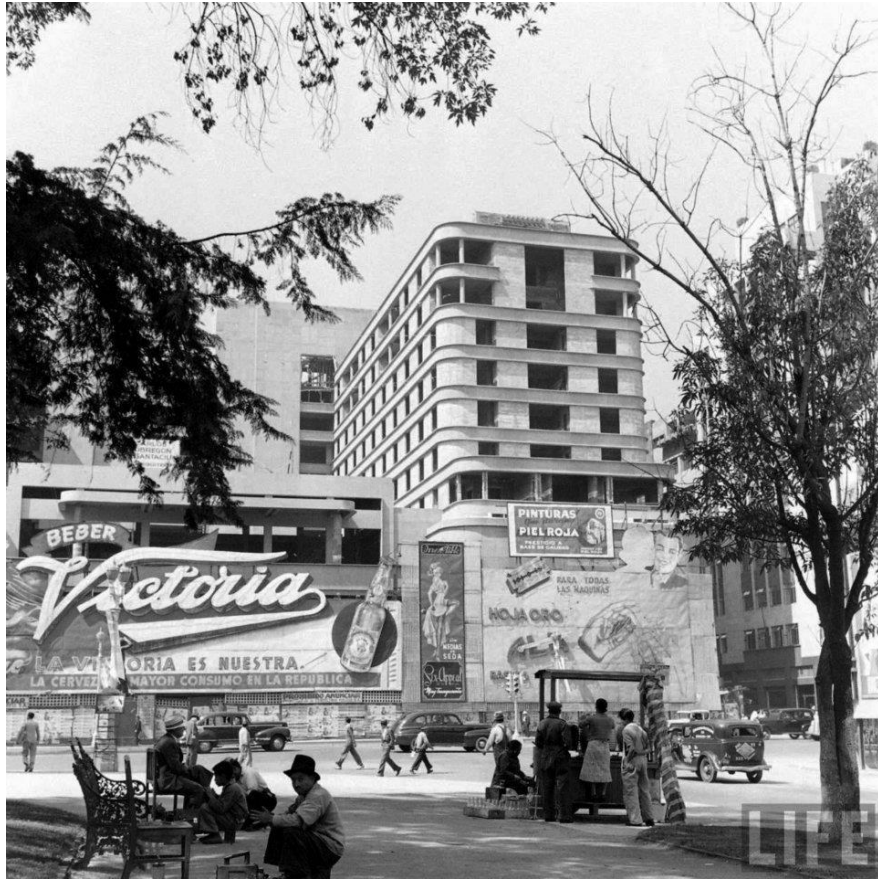
Hotel del Prado en Construcción 1945 (Fotografía de la revista Life en fb/Hotel Del Prado Mexico Df (1948-1985) Oficial)
