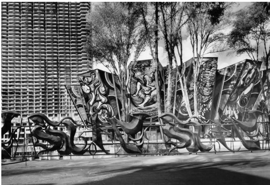
Polyforum cultural Siqueiros y Hotel de México en construcción 1971 ( http://archivo.eluniversal.com.mx )
