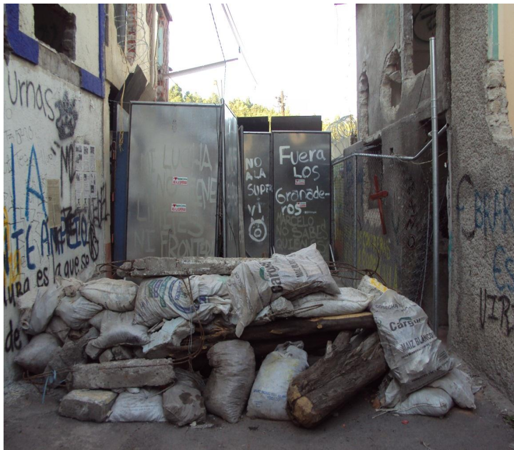
Vallas colocadas para evitar el paso hacia las casas demolidas. Fotografía tomada el 16 de enero de 2011.
