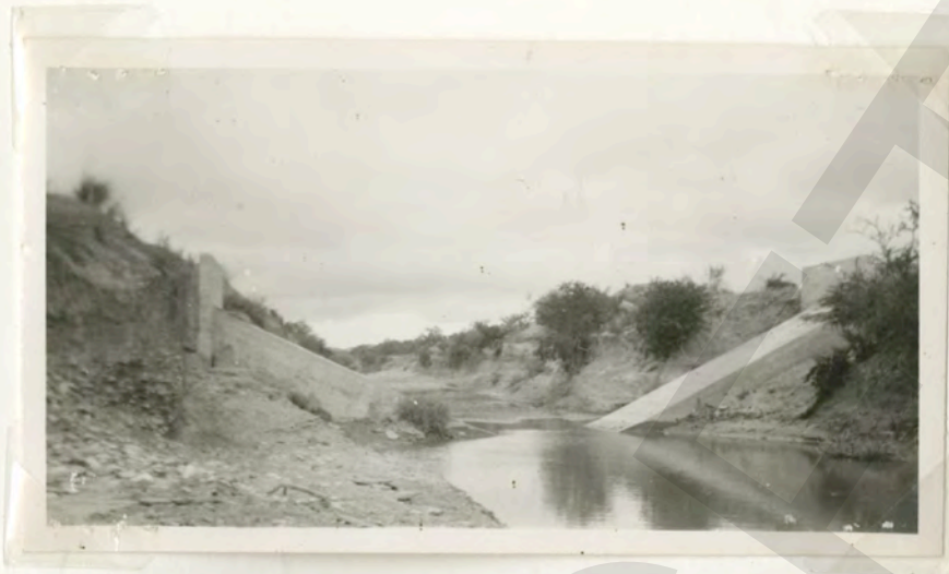
S4-15. El Sifón en el Arrollo del Moro descubierto por sus avenidas torrenciales.
