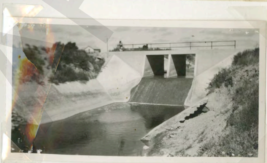
S4-17. Prolongación del zameado en uno de los Taludes del Lateral Camarón.
