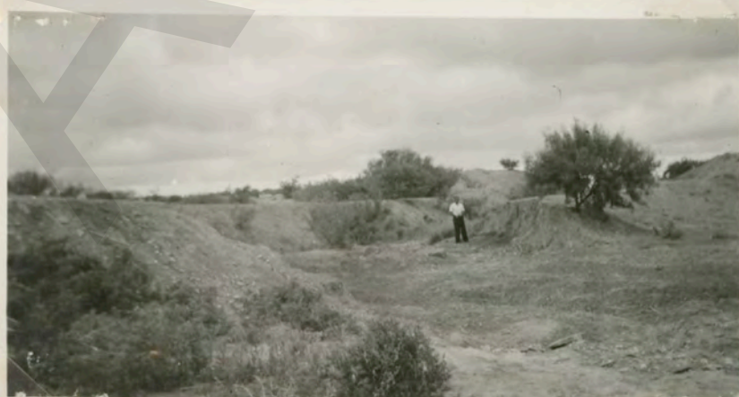
S4-10 Ruptura de 100 m en el Canal Principal aguas abajo del K 91.8
