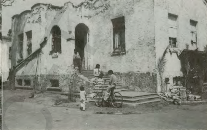
La sala de selección y peso de los huevos, así como la parte que contenía la estación climatológica y sismológica tiene este aspecto de abandono.
