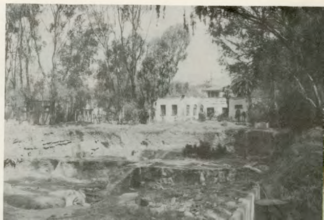
Un hoyo de cinco metros de profundidad fue abierto por los tabiqueros a unos cuantos pasos de la casa del General Calles.
