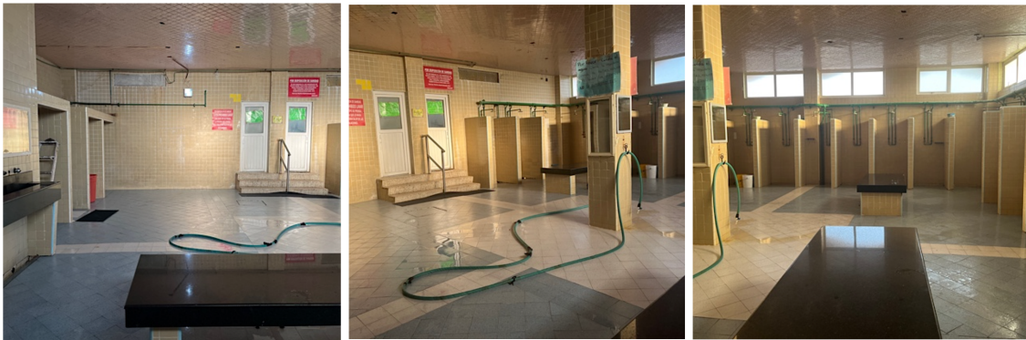
Bloque fotográfico 4. Área de regaderas en Los vapores Nava
