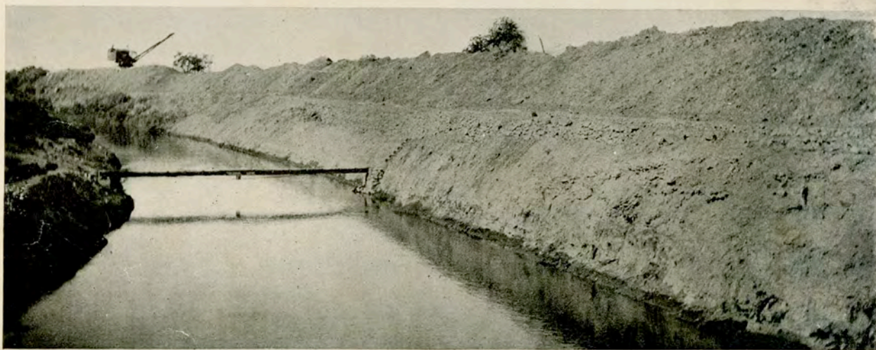
Vista del Canal Principal, abajo de la Boca-Toma en Los Hornos. El cauce del canal, abierto en roca viva por una distancia de 760 metros, más o menos, es 24 metros de ancho por 9 metros de profundidad y 57 kilómetros de largo.
