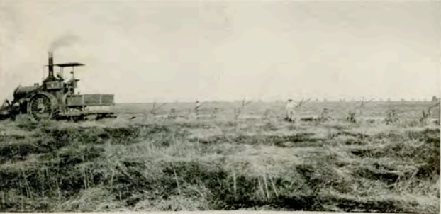
Arando 14 hectáreas de terreno diarias con una tractora que arrastra 6 arados de 6 discos.
