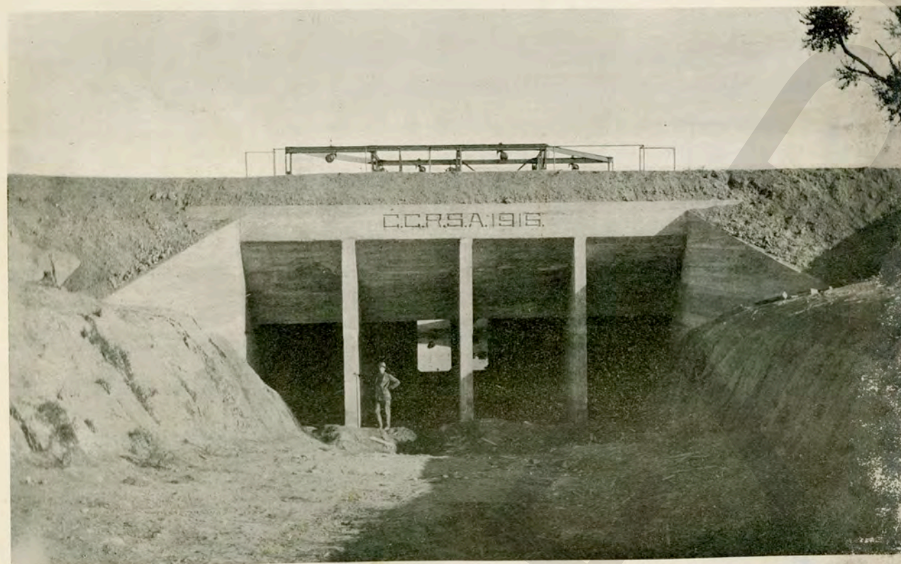
Alcantarilla construida por la Compañía en 1916 debajo del Canal Principal en el Arroyo de Bachoco para impedir que las crecientes rompan el Canal con la pérdida resultante a las cosechas.
