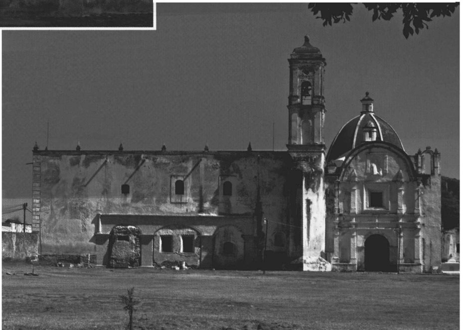
29. Capilla abierta, convento de Atlatlahucan 30. Iglesia de Jonacatepec
