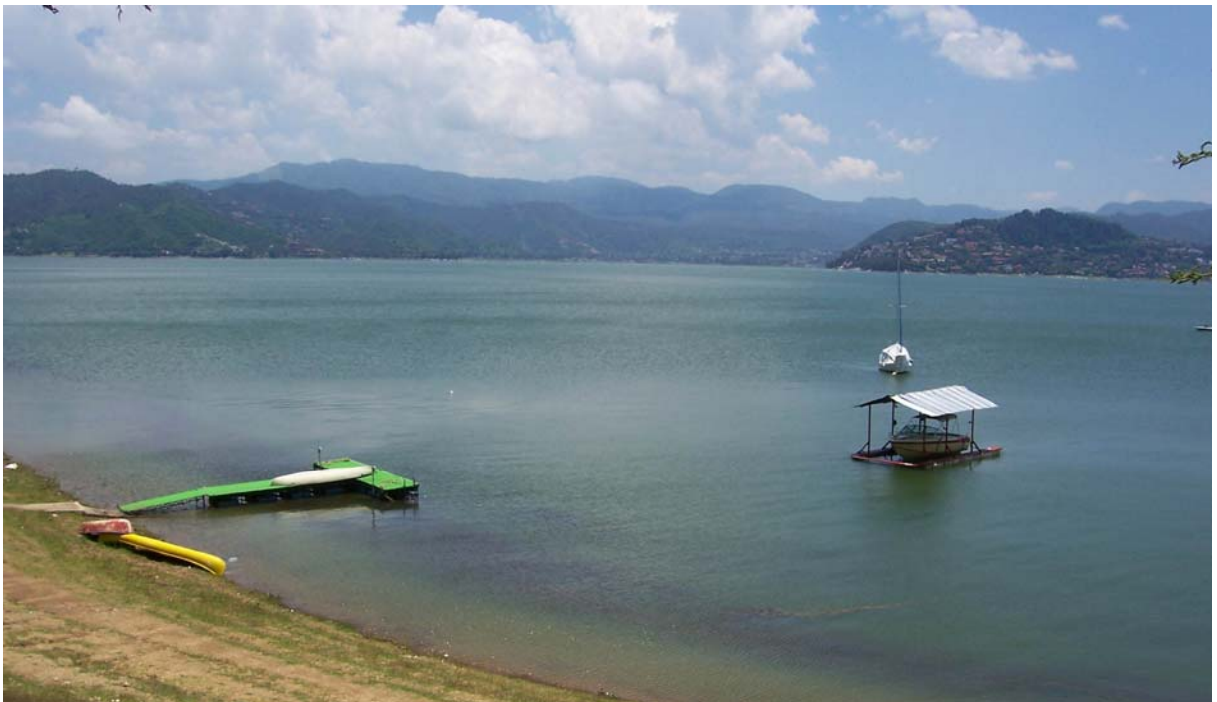
Fotografía 10. Azolves en la Presa de Valle de Bravo
