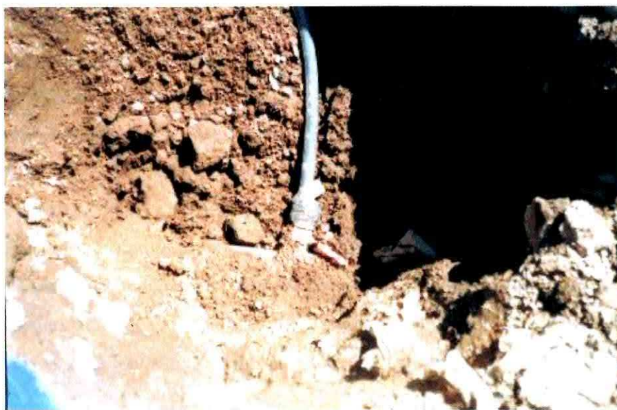
Figura 2. Reparación de fuga con cinta de aislar.
