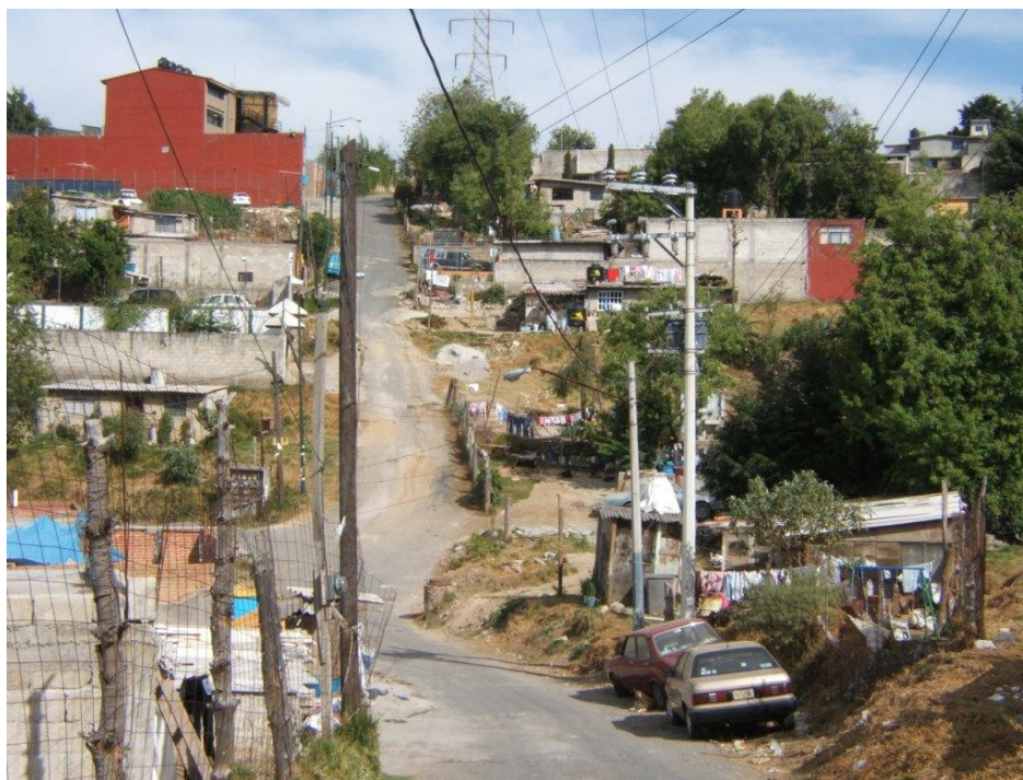
Foto 11. Pavimentación que se llevó a cabo después de la firma del Convenio de Crecimiento Cero
