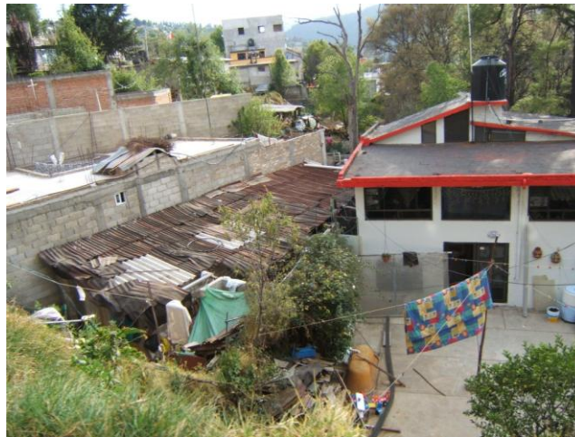
Foto 9. Lote con el primer cuarto construido con materiales temporales y la vivienda sólida mandada hacer por encargo
