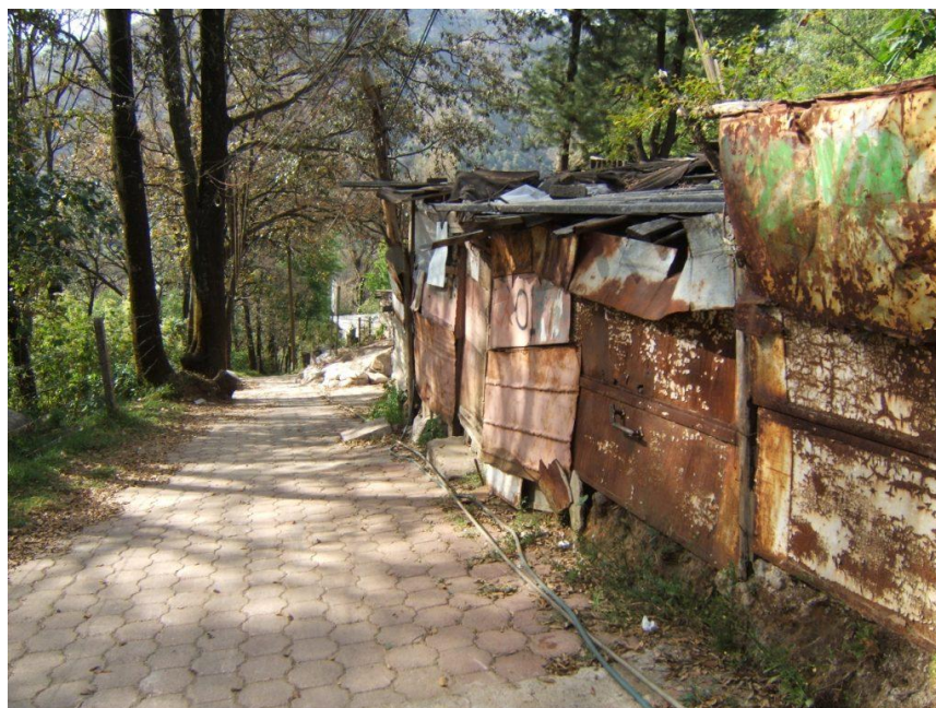
Foto 14.- Andador y vivienda auto construida con material de desecho.
