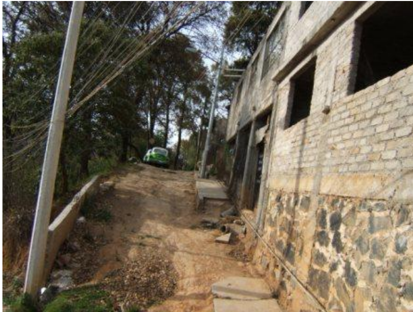
Foto 16.- Andador y la madeja de alambre de conexiones a la red eléctrica ilegales.
