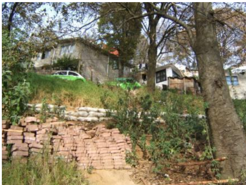
Foto 18. Muros de contención hechos con costales de arena y circulación de taxis
