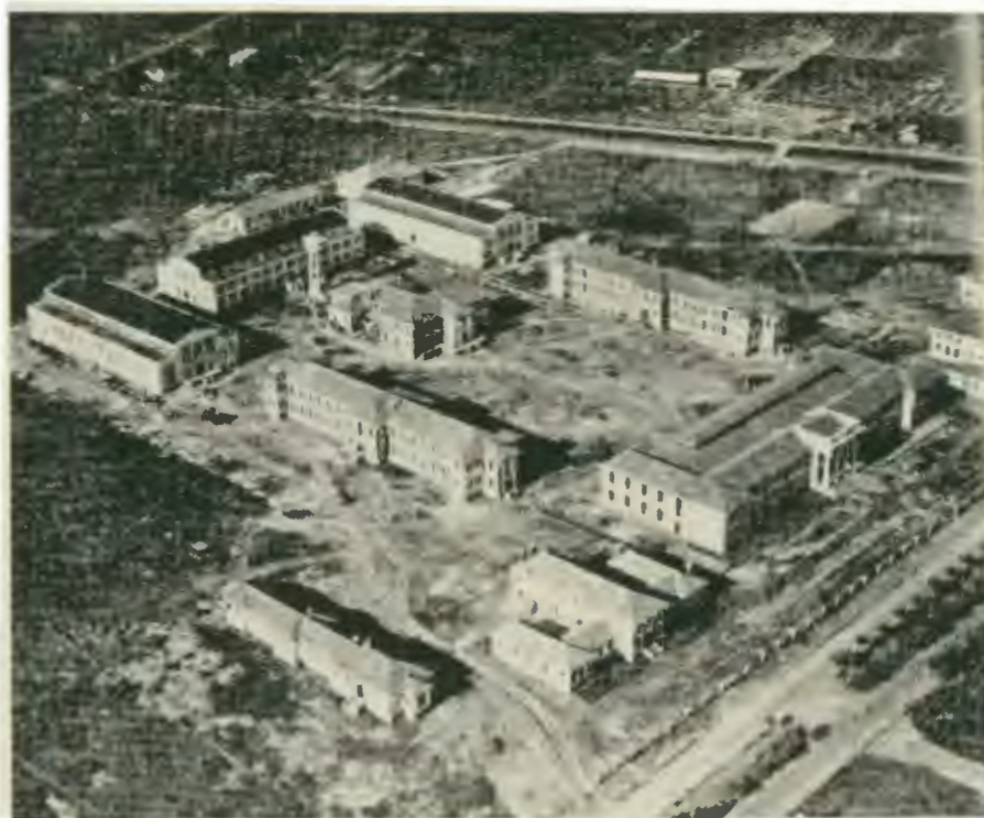
Figura 39. Predio de la ESMA ( Escuela de Mecánica de la Armada ) hacia 1927. Fuente: Brodsky, Marcelo (comp.): ESMA: Memoria en construcción , p. 48.
