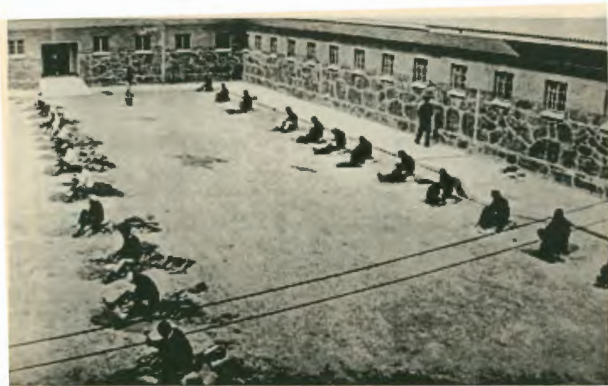
Figura 10. Patio de trabajos forzados. Robben Island. Fuente: Mayibuye Archive Collection.
