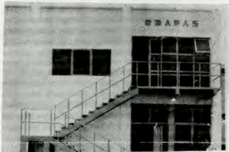
A vista del moderno edificio de las oficinas de Agua Potable y Alcantarillado inaugurado en Ixtapaluca por el Gobierno del Estado de México, Ignacio Pichardo Pagaza.
