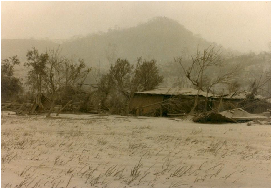
Foto 8. Viviendas destruidas en el municipio de Chapultenango FUENTE: Archivo personal Silva
