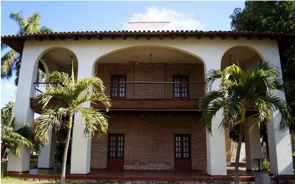
Fig. 83. Fachada frontal de la llamada Casa Chapman, construida en 1903.
