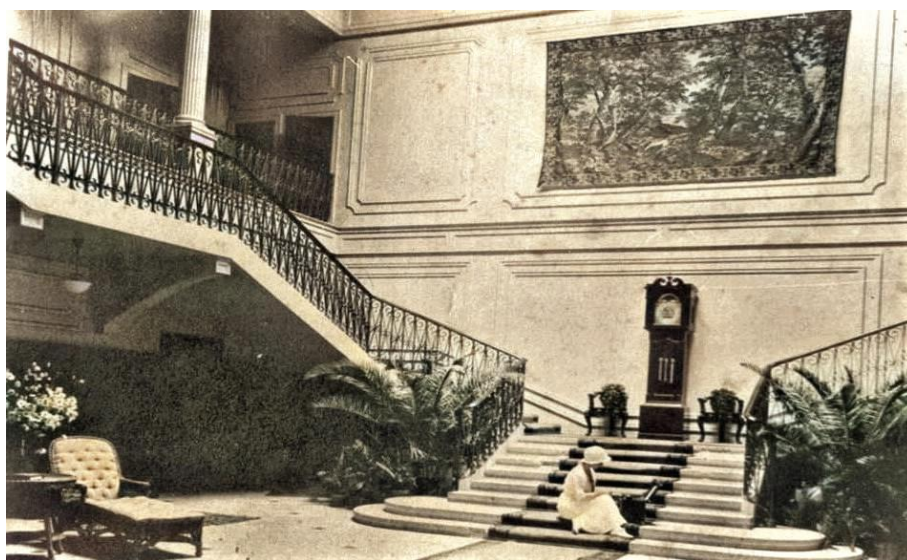
Fig. 85. Sala de estar de la Casa Johnston. c. 1905. Se observa una parte del recibidor, y la escalera de abanico. El barandal era de hierro forjado. 599
