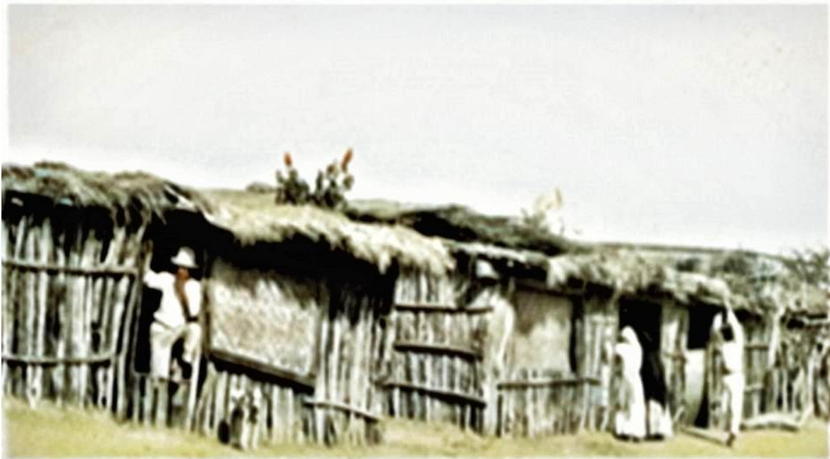
Fig. 10. Utilización de esteras de palma tejida en puertas y ventanas de las viviendas tradicionales. Pótam, Sonora. 1924. 172
