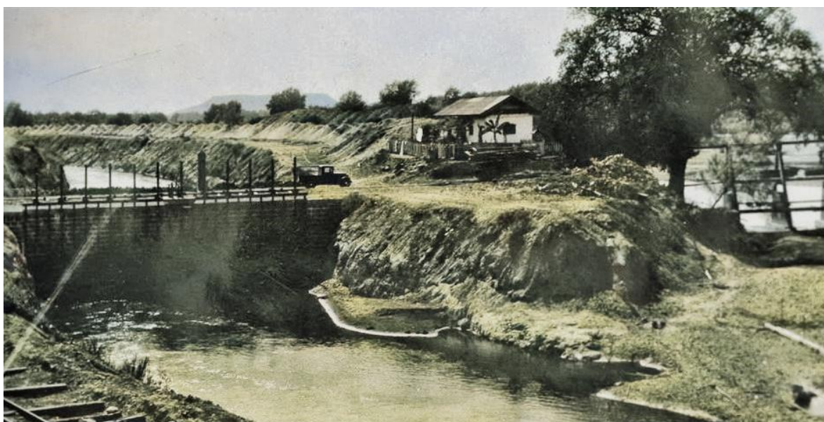
Fig. 78. Vista del canal principal y levantador de la Calle no. 2. Al fondo se observa la vivienda asignada al operador de la compuerta. Valle del Yaqui, 1910. 567
