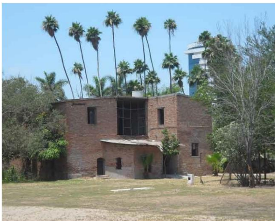
Fig. 81. Fachada frontal de la Casa Varsovia en 2012. 589
