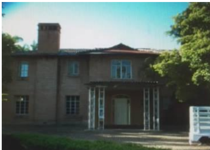
Fig. 87. Fachada de otra de las viviendas de la Colonia Americana en Los Mochis, Sinaloa. Se ve la chimenea de ladrillo rojo y la deja que cubre los techos, así como parte del jardín frontal.
