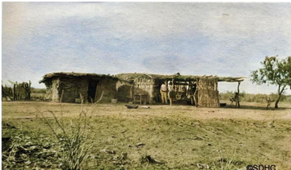
Fig. 6. Vivienda mayo de dos piezas: construcción de cuatro paredes de vara riplada con suelo de tierra, abertura para puerta y techo de terrado, un cobertizo con tres paredes de vara riplada y natural, y la ramada en la parte derecha. Navovaxia, Sonora, 1922. 165
