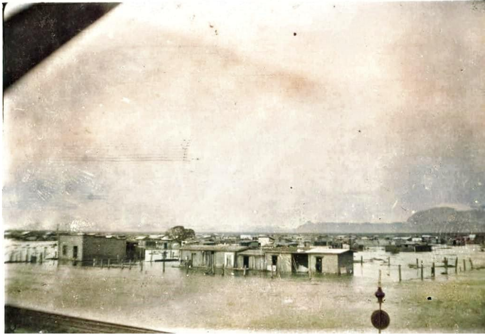
Fig. 88. Vista de la colonia Plano Oriente de Ciudad Obregón, 1932. Se observan viviendas de autoconstrucción de madera y adobe. 616
