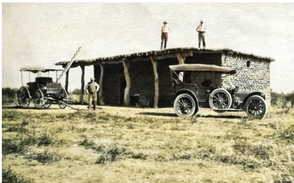
Fig. 72. Casa de habitación de una familia de colonos extranjeros del Valle del Yaqui. Se observan las paredes de adobe y el techo de terrado con un portal de madera. c. 1908. 559
