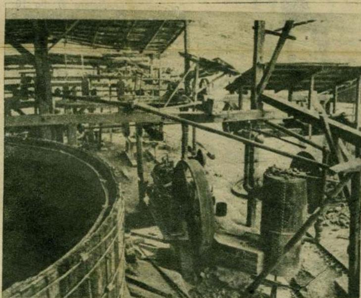
Aquí se aprecia un arco del tanque Pachuca más grande que existe en la mina, de 12 metros de diámetro por cinco de altura.
