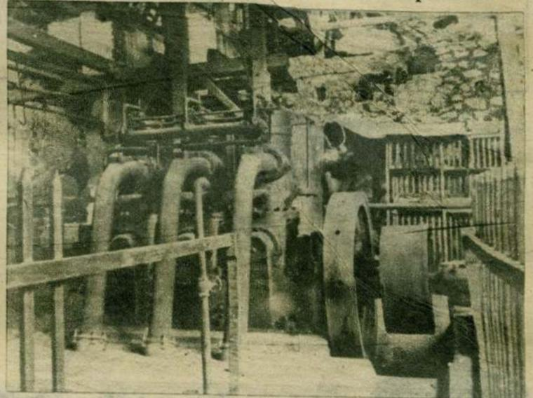
Estos tres tubos servían para ascender el agua desde el río que conducía el agua de la Presa que a 10 kilómetros de la mina construyó la misma compañía.
