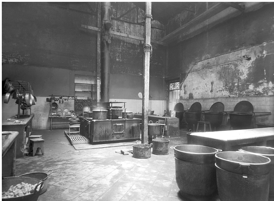
Foto 6. Interior de la cocina del Manicomio General. Fototeca INAH, Fondo Culhuacán, inv. 366893
