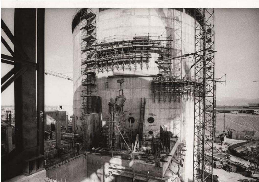
Fotografía 3: Construcción de parque nuclear a partir del plan Messmer
