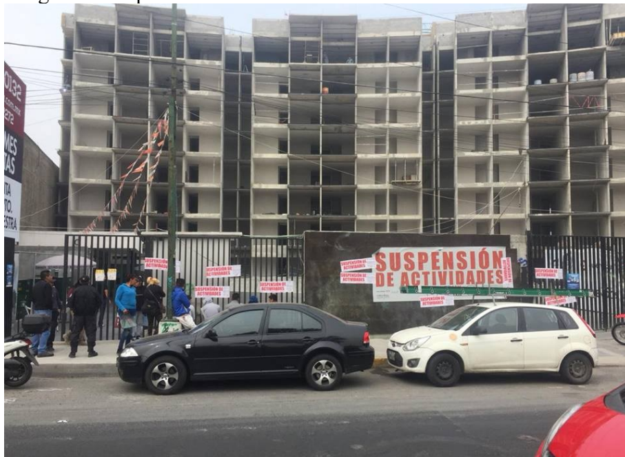
Fig. 2.15 Suspensión de actividades en la obra el 11 de diciembre de 2018
