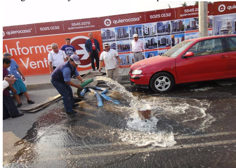
Fig. 2.11 Flujo de agua al drenaje evidenciado en una protesta frente a la obra
