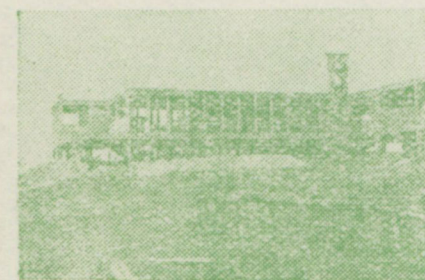
HOSPITAL - SANATORIO (En construcción) Tampico, Tamps. OBRA DEL COMITE LOCAL
