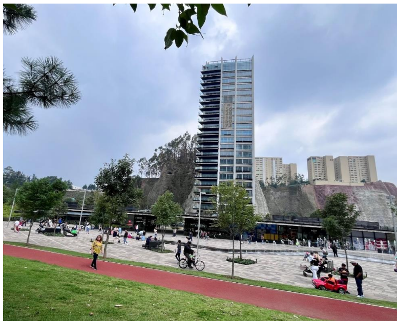
Fotografía propia de la torre NAARA terminada, tomada el 28 de julio de 2024.
