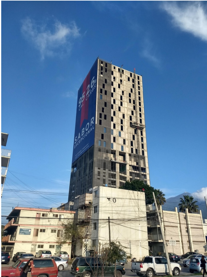
Foto tomada durante el trabajo de campo
