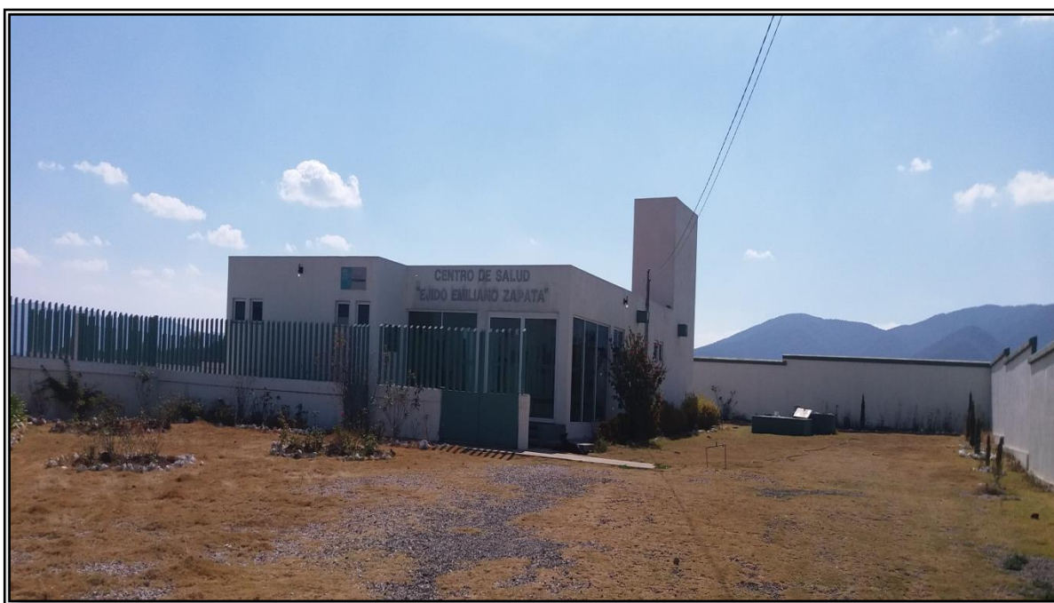
Imagen 4.1 Clínica del Barrio Emiliano Zapata del ejido de San Felipe Coamango
