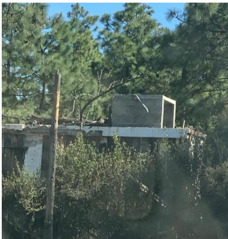
Fotografía 14. Caseta de vigilancia abandonada por enfrentamiento armado
