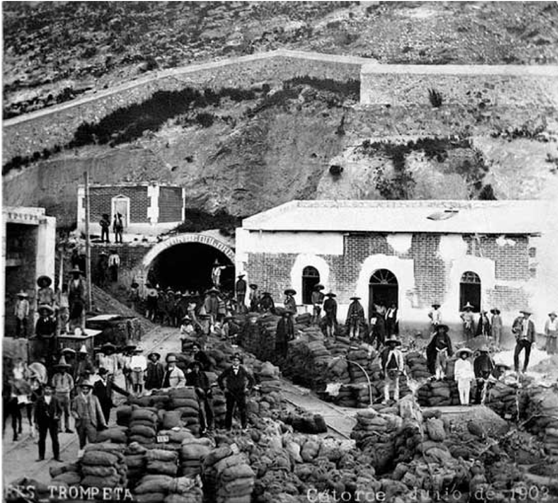
Acceso al túnel de Ogarrío en la Hacienda de Dolores Trompeta en Real de Catorce, San Luis Potosí, 1903, FN, INAH, Pachuca, Hidalgo, México.
