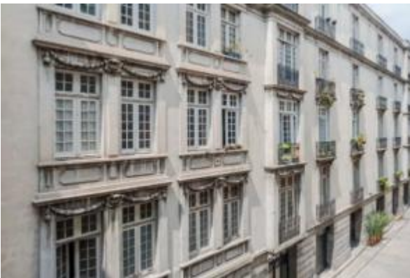
6: Aspecto actual del patio central del Edificio Vizcaya
