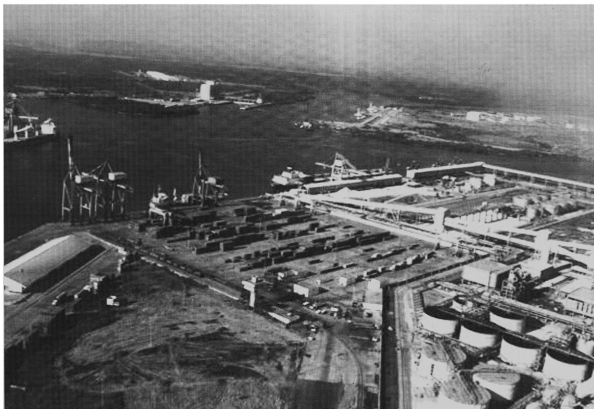
FIGURA 5a. Puerto de Lázaro Cárdenas. En primer plano, la terminal de carbón de CARBONSER. Al fondo, tanques de almacenamiento de PEMEX (fuente: InfoPort, S.A. de C.V., 2000).
