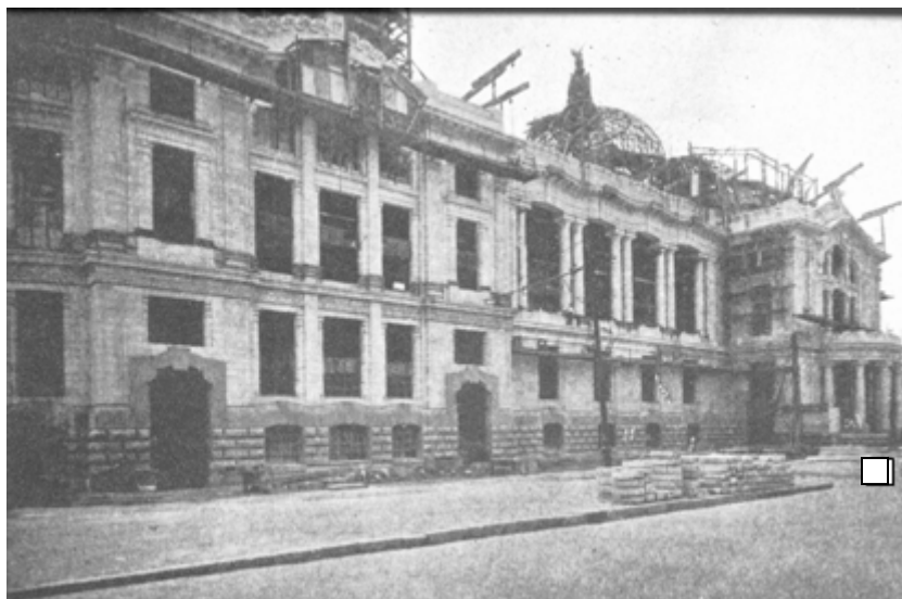
FIGURA 30 Teatro Nacional, ca. 1909 Fachada lateral en construcción. Arquitecto Adamo Boari
