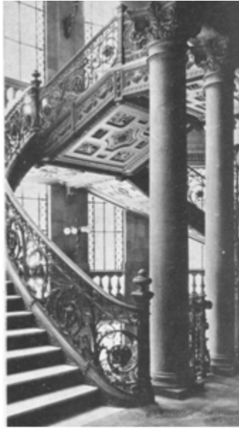
FIGURA 41 Palacio de Comunicaciones, 1911 Escalera principal. Detalle
