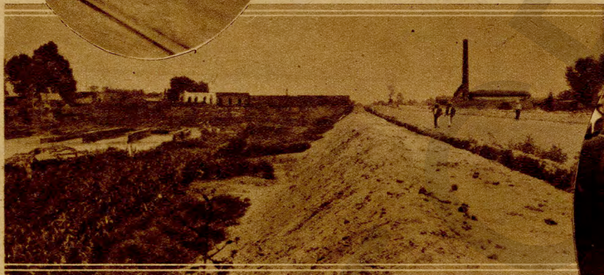
Uno de los grandes terraplenes que fue necesario construir en las oquedades de las antiguas ladrilleras
