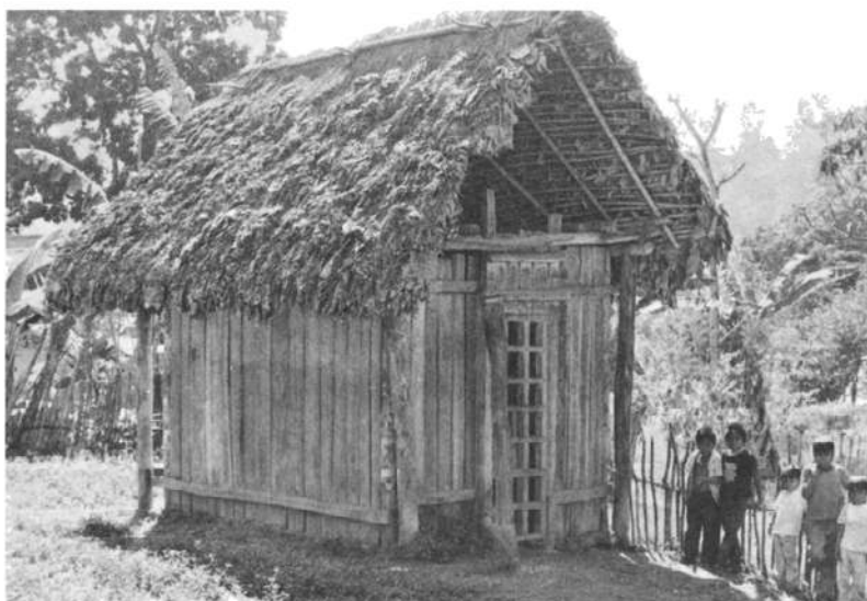
El lenguaje utilizado en esta edificación no está vigente pero es útil como antecedente de las edificaciones posteriores
