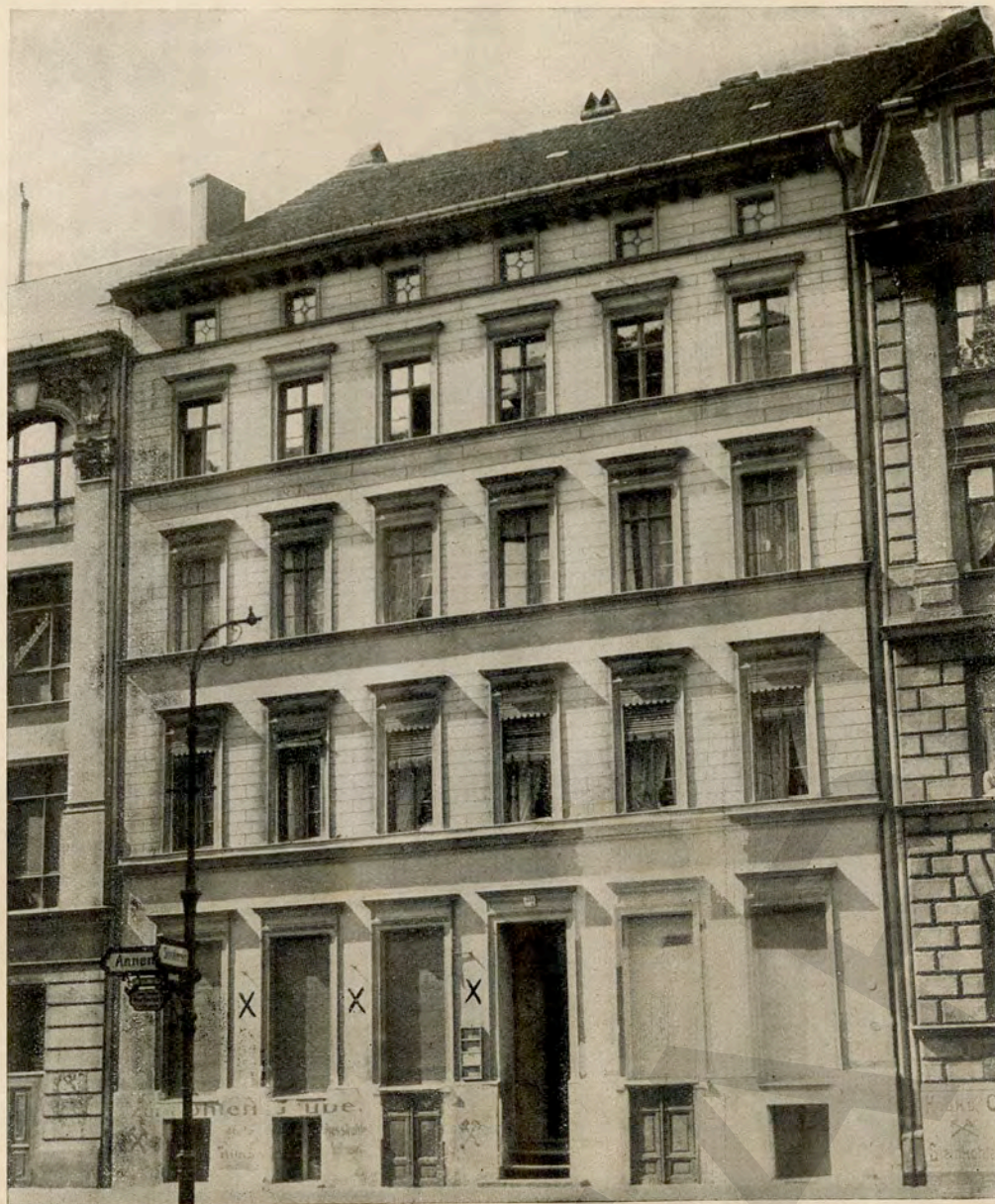
1897–1900. Erstes Verbandsbureau der Verwaltungsstelle S 14, Annenstraße 39
