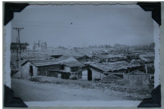
Imagen 6. "Vistas parciales de la población", Santiago, 1945.
