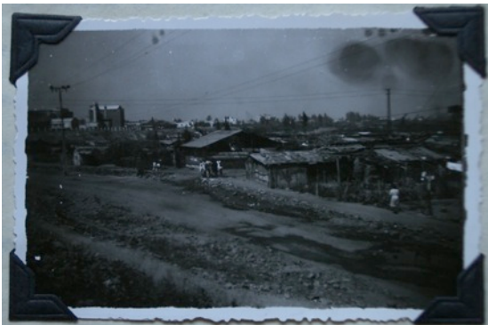
Imagen 5. "Vistas parciales de la población", Santiago, 1945.
