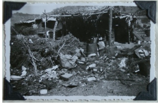
Imagen 4. "Viviendas típicas de la población arenera", Santiago, 1945
