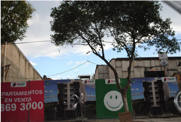
Imagen 11. Predio en obras de construcción de edificio habitacional
