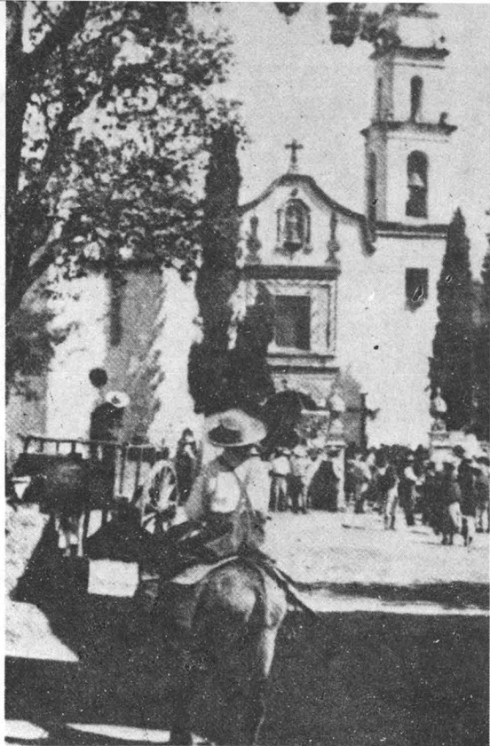
Bledos. Vista exterior de la capilla
