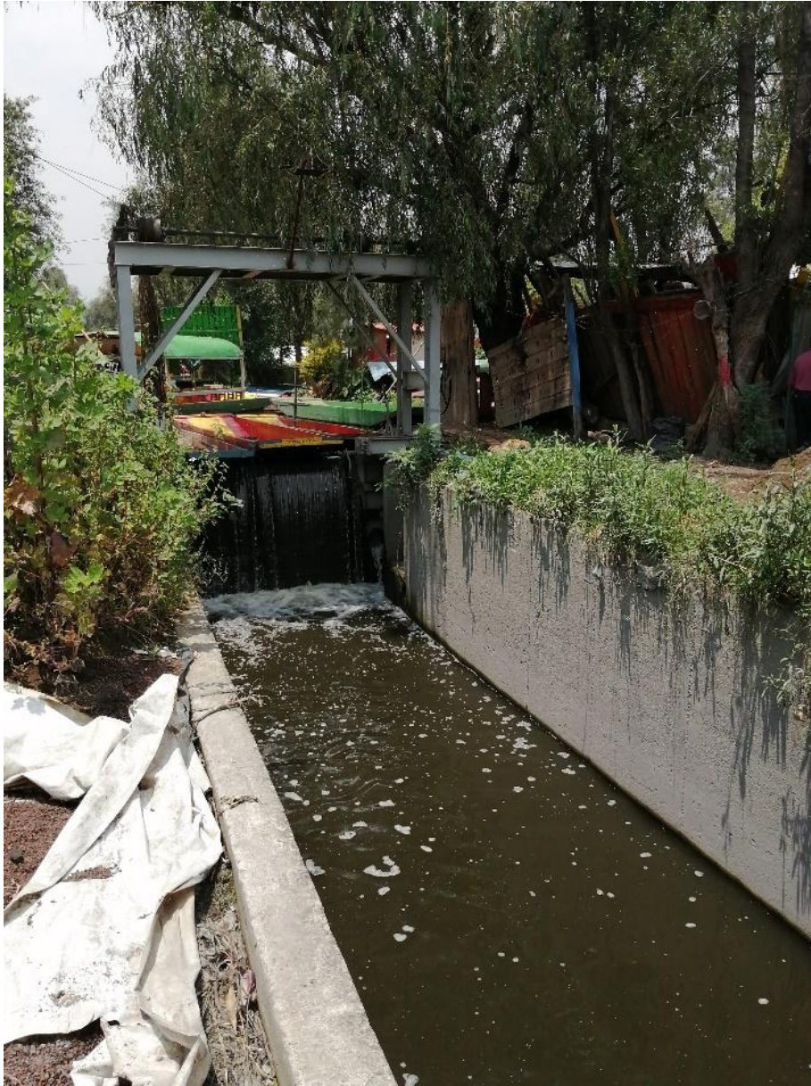
Fotografía 6.2 Esclusa que divide las aguas de Caltongo y Nativitas del resto de la red canalera
