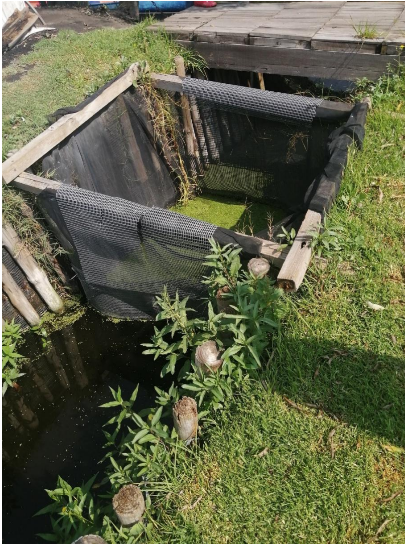
Fotografía 5.3: Biofiltro en construcción
