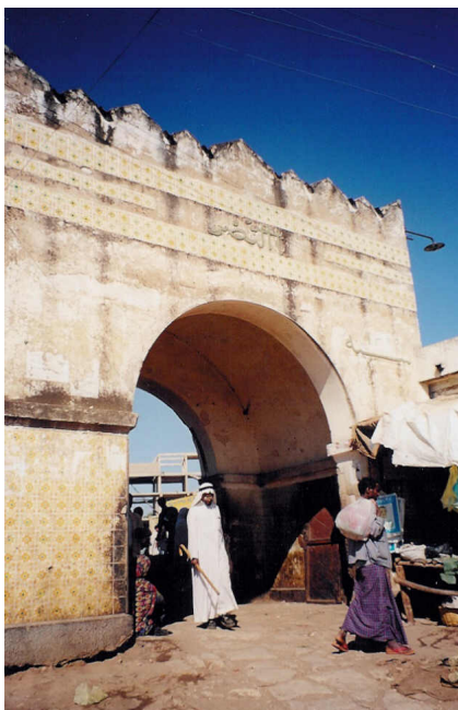
Figura 5.7: Vista de una de las puertas del Jogol de Harar Las paredes que rodean a la ciudad fueron construidas entre los siglos XIII y XVI Fuente: Harar Jogol listed as a world heritage
