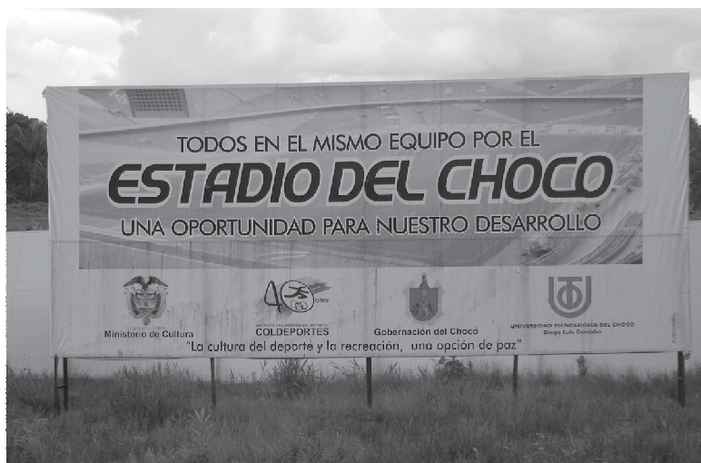
Foto 1. Construcción del Estadio del Chocó en predios de la Opoca. Vía carretable Quibdó- Yuto, junio de 2009.
