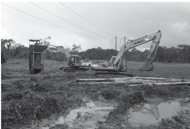
Foto 2. Aplanamiento de un terreno minero. El Salto (Río Andágueda), junio de 2009.
