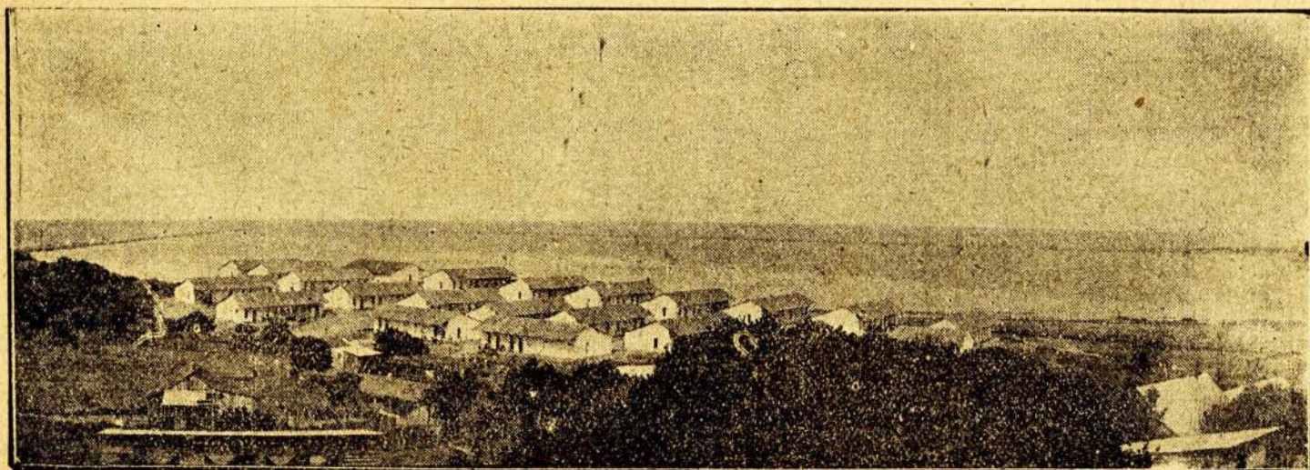
Puerto México.—Escolleras en la desembocadura del Río Coatzacoalcos.
