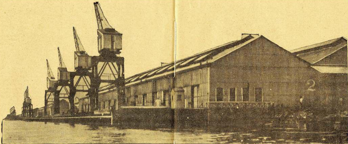
Vista general de los almacenes y muelles del Puerto Libre de Puerto México.—Nótese las 18 grúas eléctricas de 3 toneladas de capacidad con que se cuenta en este Puerto.—La Planta especial de fuerza eléctrica que existe en este Puerto Libre proporciona la potencia necesaria para manejar estas grúas a toda carga y muy económicamente.—Véanse tarifas.
