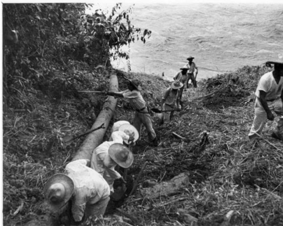
Fuente: “Hombres cavan zanja a orillas del río en la reparación de un oleoducto”, Foto Mayo, 1 de octubre de 1944, Mediateca-INAH, en <https://mediateca.inah.gob.mx>
