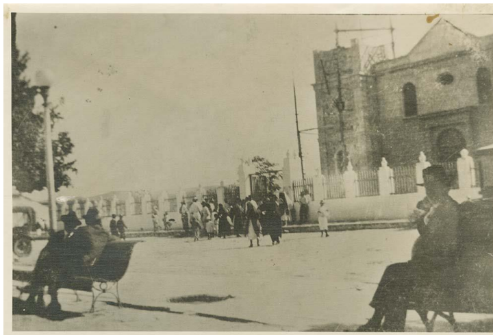
Imagen 7. Construcción de la segunda torre del templo de Nuestra Señora de La Paz, 1919. 75
