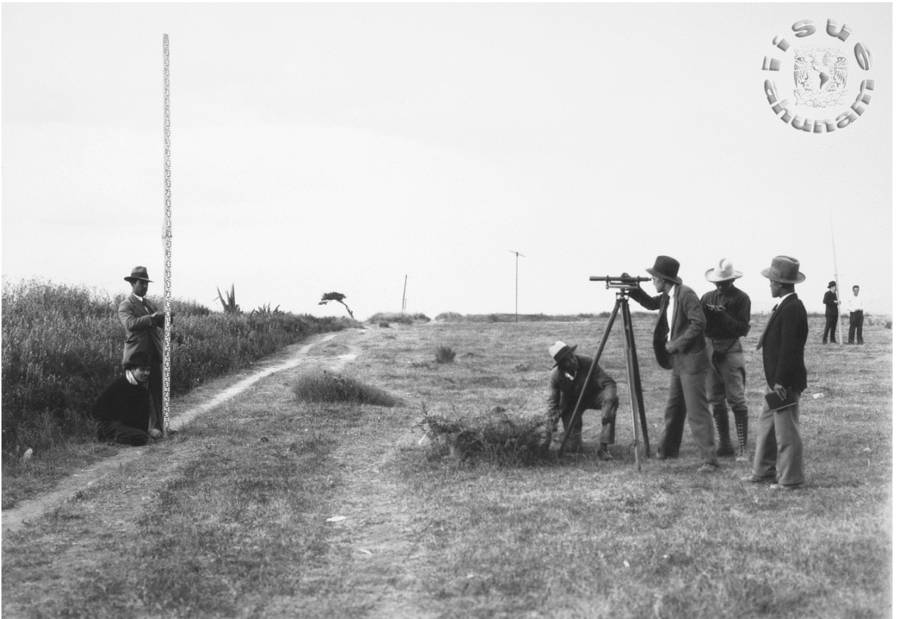
Alumnos de ingeniería realizando el levantamiento topográfico en los terrenos de la Ciudad Universitaria, 1930. AHUNAM, Fondo Alicia Alarcón, caja 7, Doc. 519.
